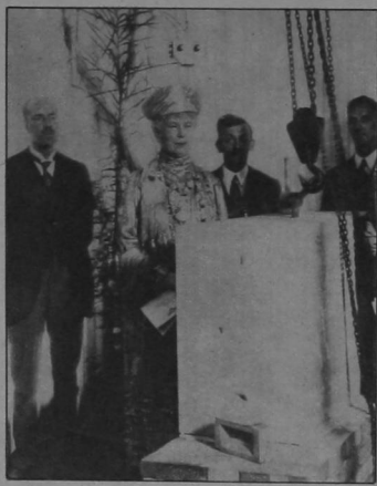
S. M. la reina María de Inglaterra, coloca la primera piedra del nuevo edificio de la Y. M. C. A., Tottenham Road, Inglaterra.
